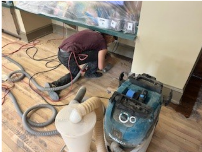
Sanding wall edge
