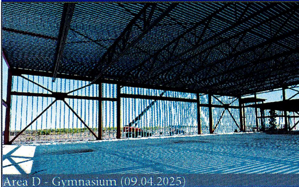
Area D - Gymnasium (09.04.2025)
