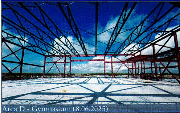
Area D - Gymnasium (8.06.2025)
