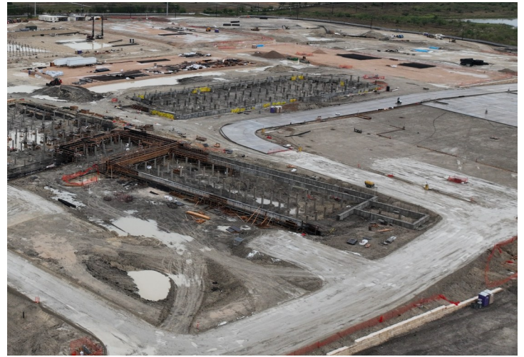
Pour Grade Beams - Area D
