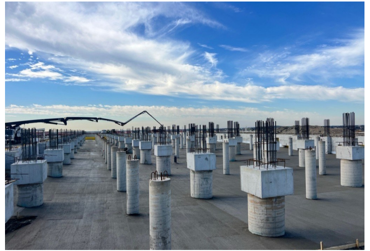
Pour Mud Slab - Areas A & B
