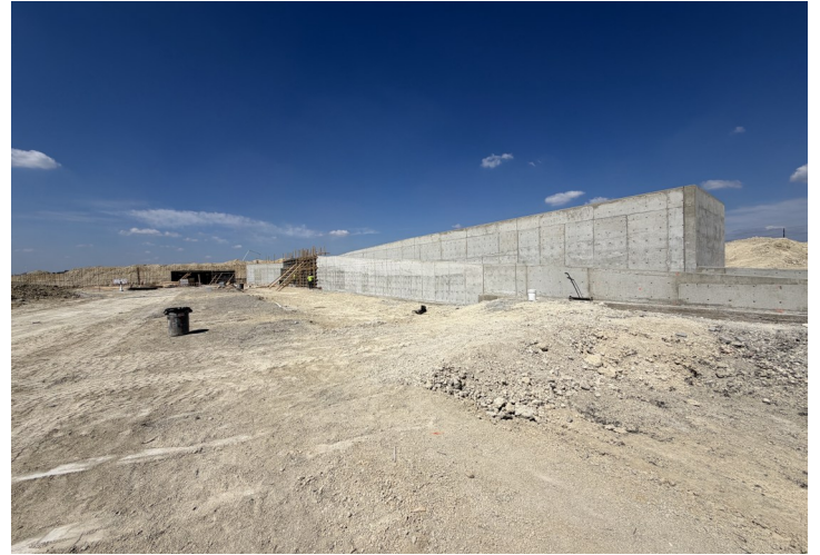
Pour CIP Wall #2
