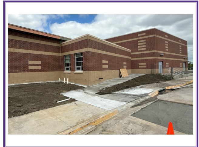
Sidewalk Ramp Poured
